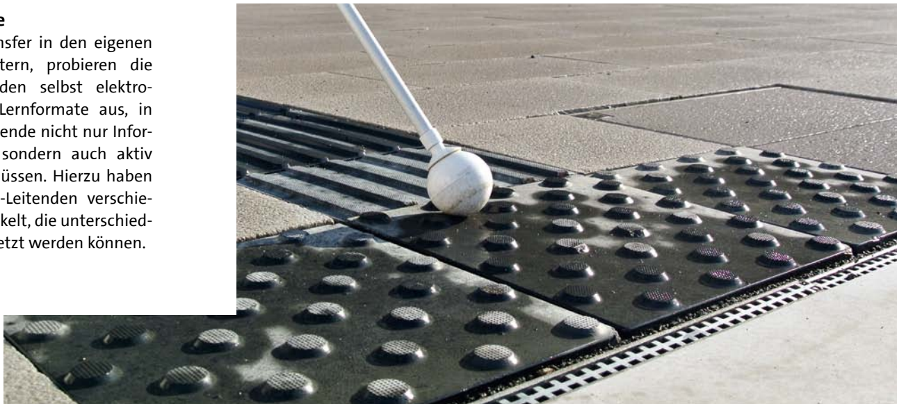
Abbildung 2: Blindenleitsystem.
